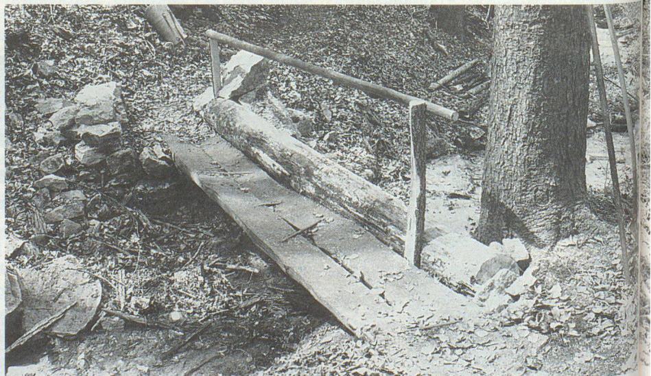
Brücke mit neuem Geländer.
