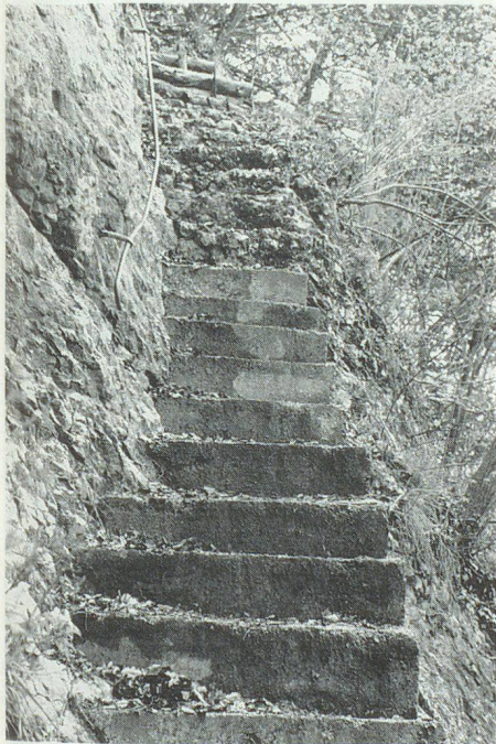
Nicht gesicherter Weg.
