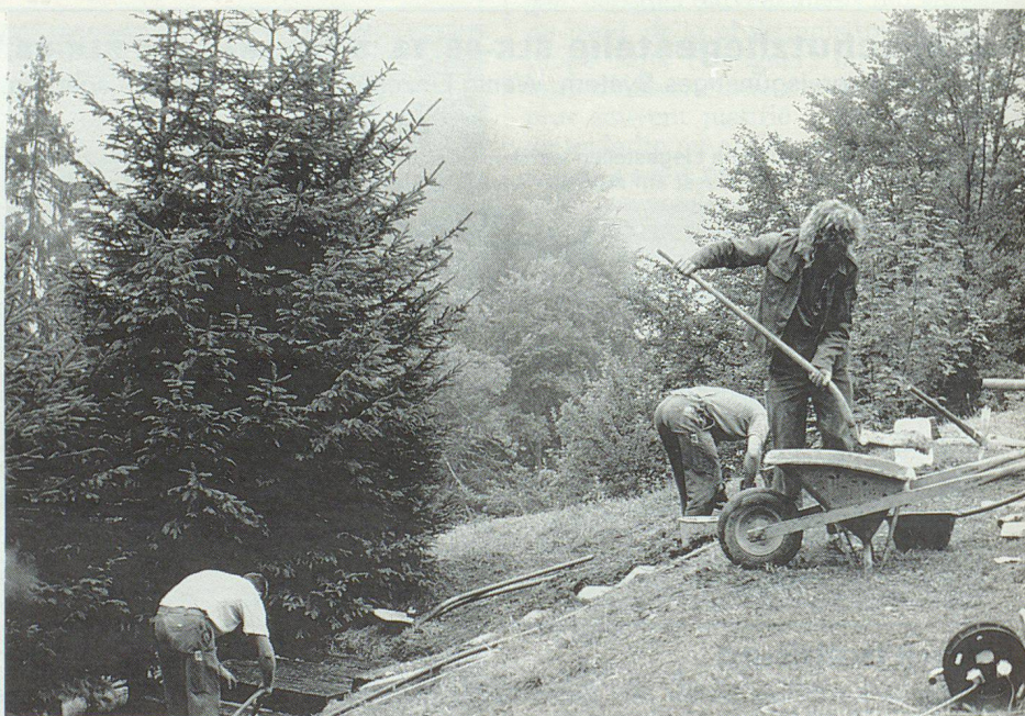
Les escaliers conduisant au terrain de foot: finition et nettoyage.
