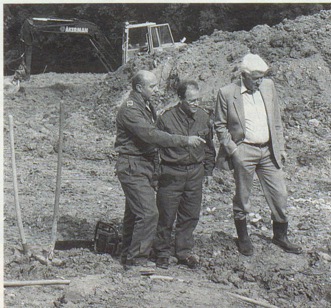
Besichtigung auf einer der über 100 Baustellen. Von links: OC-Stellvertreter Alois Schaller, Ortschef Ferdinand Brühlmann, Franz Baumeler, Chef des Luzerner Kantonalen Amtes für Zivilschutz.
