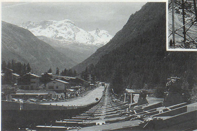
Vue du pont construit par l'armée sur des bateaux pneumatiques.
