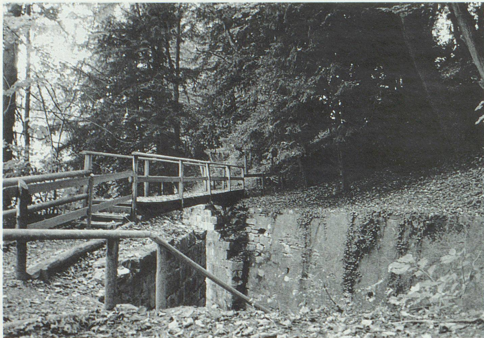
Une passerelle toute neuve surplombant l'ancien funiculaire Vallon-Sauvabelin.
