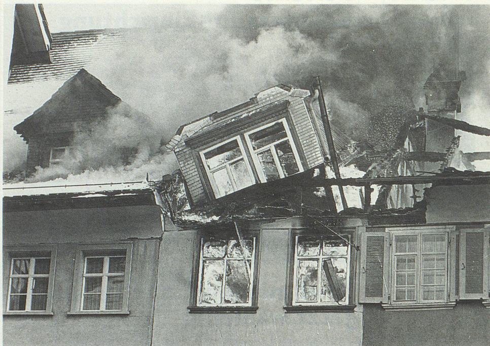
Der Brand brach im Dachstock eines der zusammengebauten Häuser aus.
