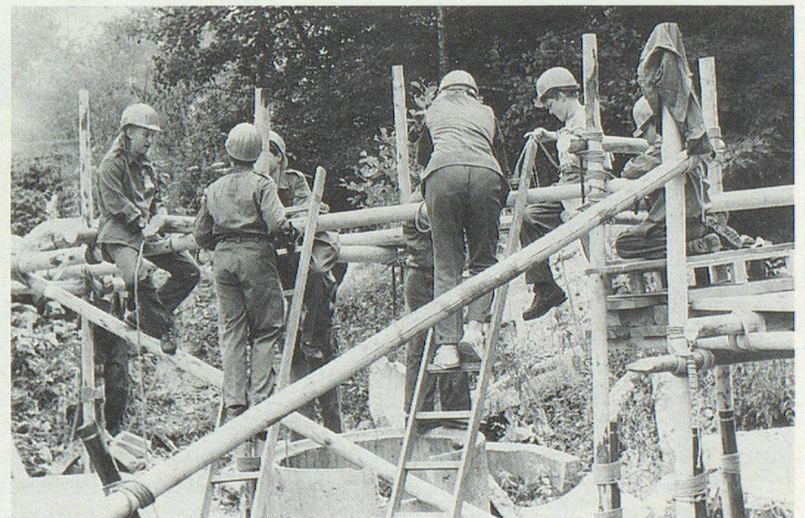
Brückenbau in schwierigem Gelände.
