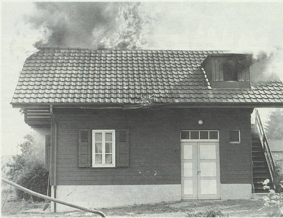
Ein Gebäude ist in Brand geraten.
