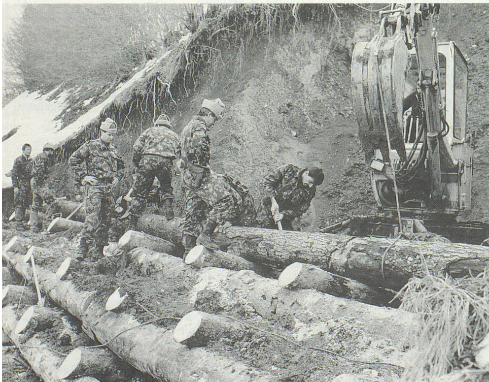
Profimässige Verbauung am «Hofuri» durch Wehrmänner des G Bat 32.
