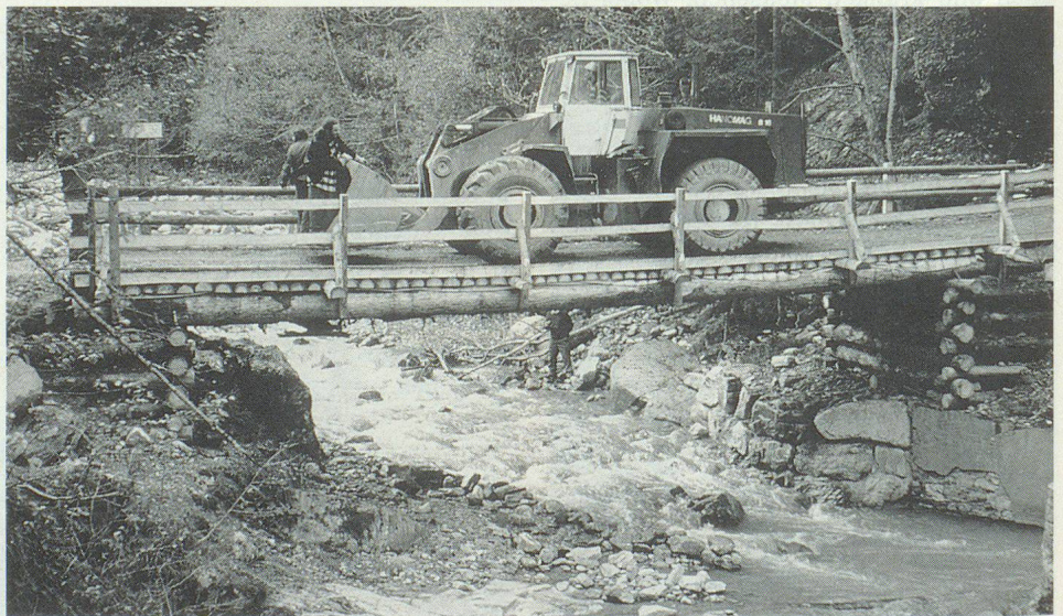
«Für alle Fälle»: Der Zivilschutz erstellt nach einem Unwetter eine neue Brücke.
