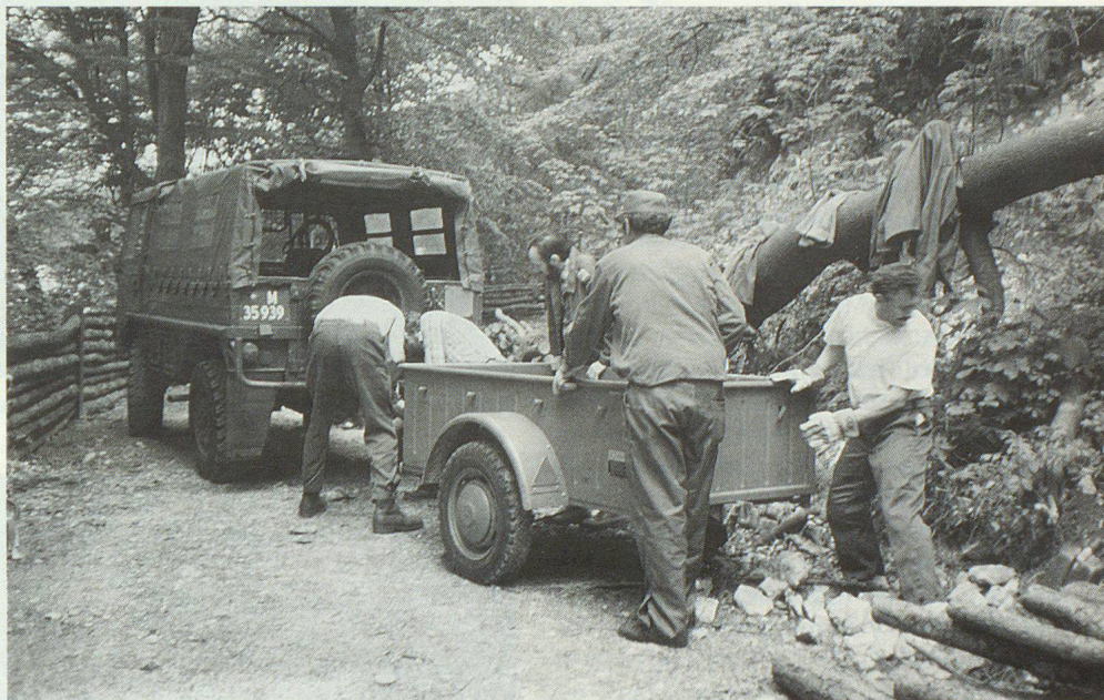
Materialtransport für die Instandstellung der Wanderwege.
