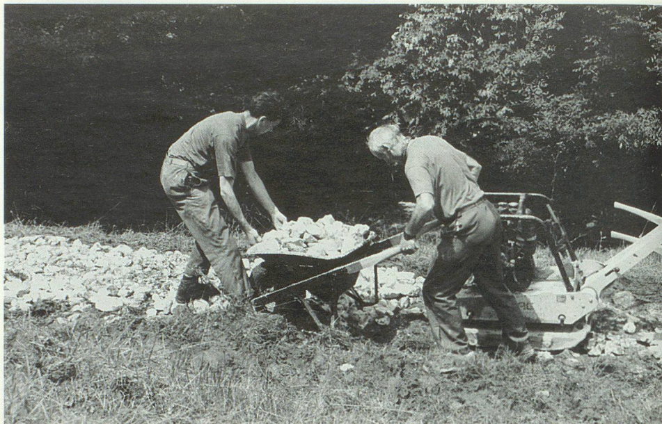
Zivilschützer bei der Sanierung eines Fussweges.
