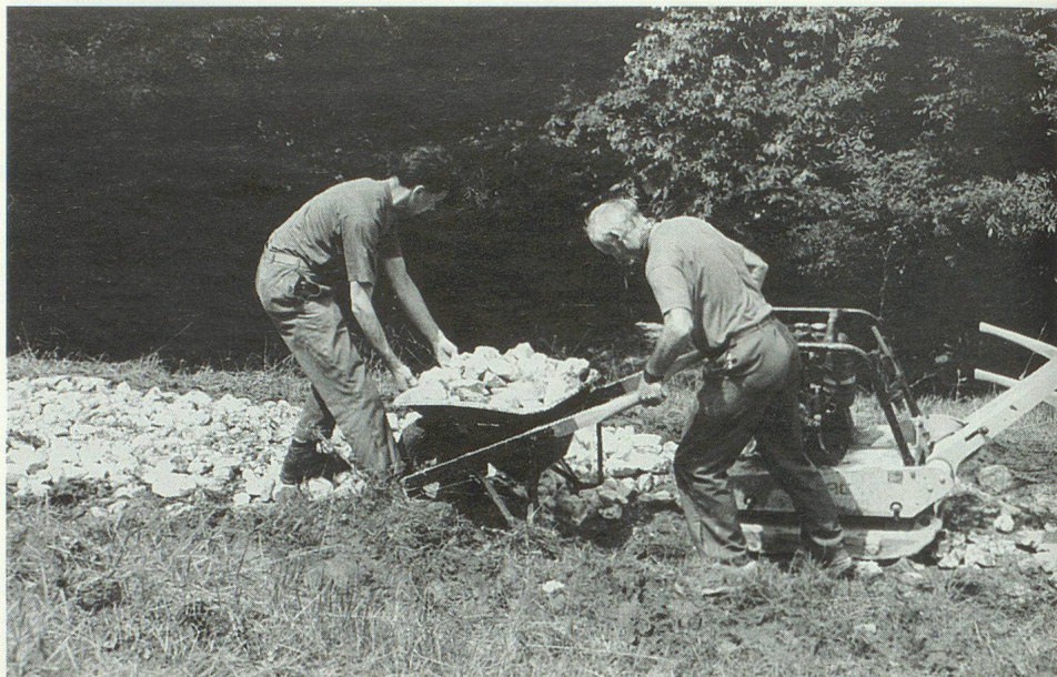
Zivilschützer bei der Sanierung eines Fussweges.
