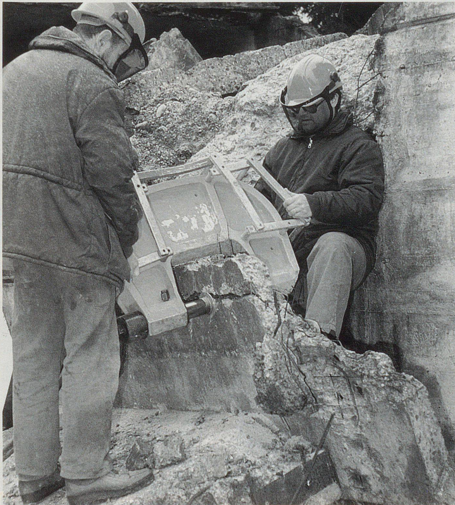
Einsatz eines Beton-Beissgerätes.
