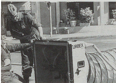
On évacue les gaz des canalisations.
