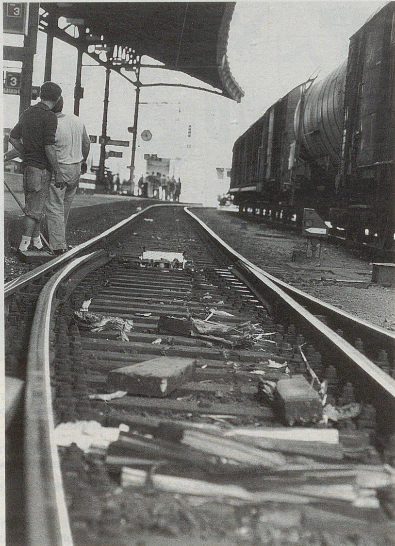
Les traces du wagon sur le ballast.
