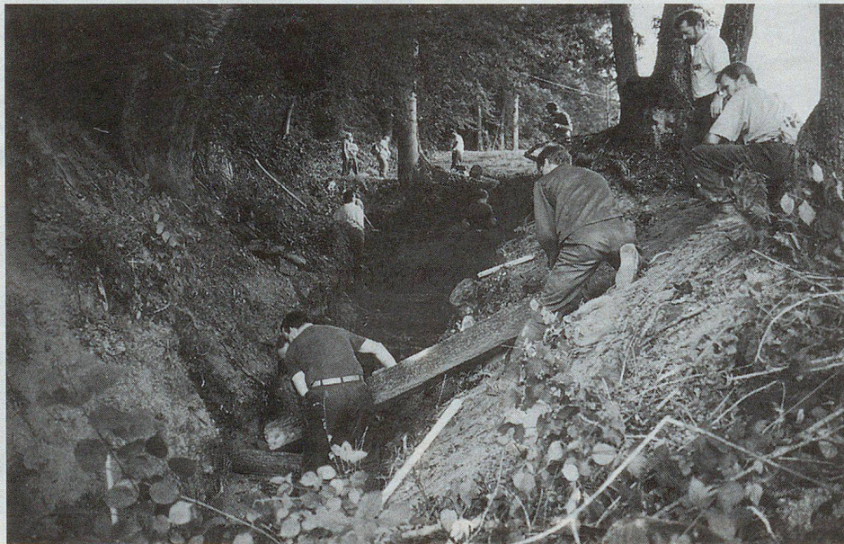
Am Belpberg werden Eichenschwellen in ein Bachbett eingebaut.
