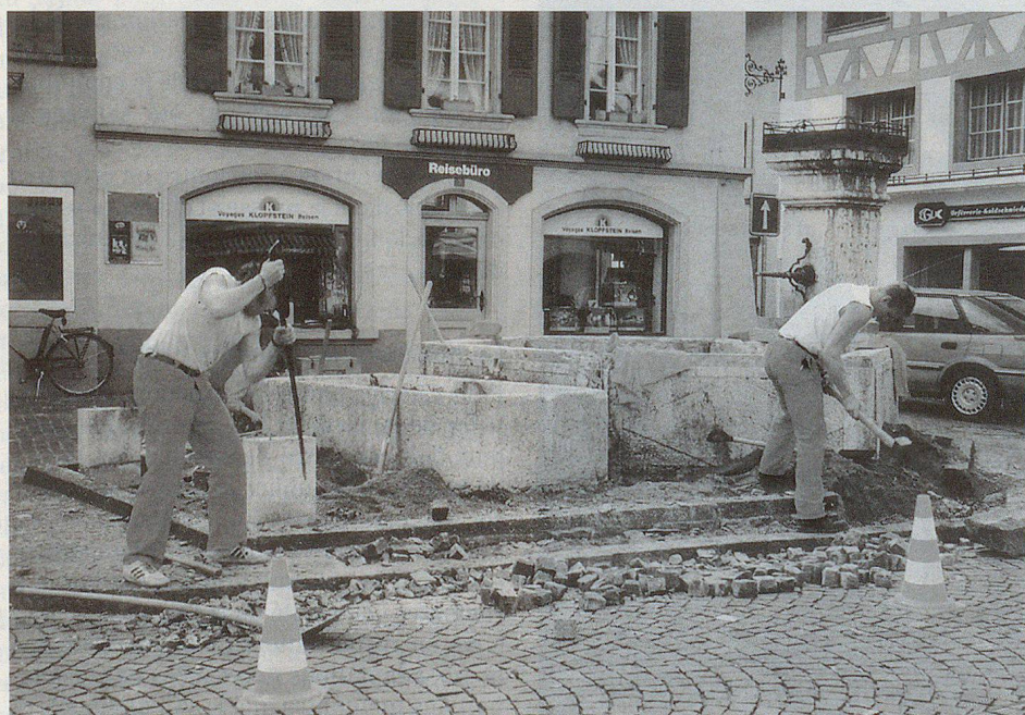
Sanierung des Rübenlochbrunnens im oberen Städtchen.
