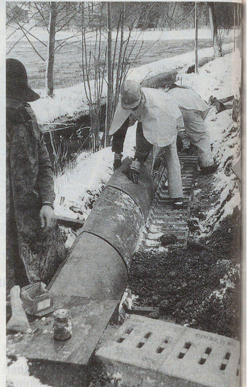
Über 300 Meter Leitwände und Amphibientunnel wurden verlegt.
