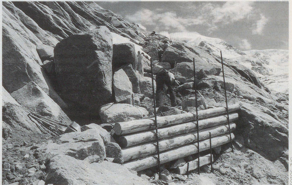
Der Weg wird mit massiven Rundhölzern gesichert.
