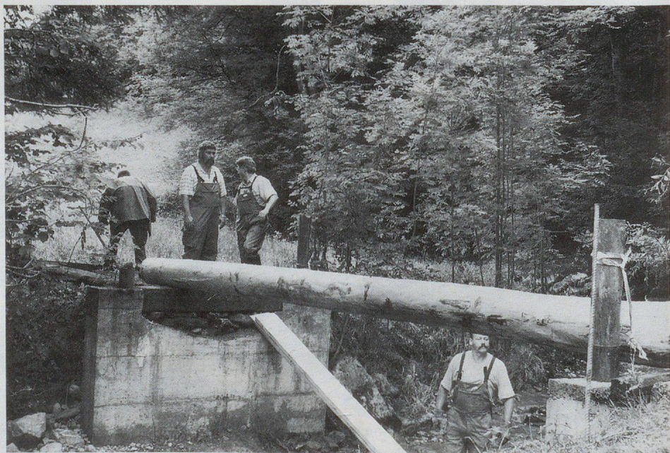
Zivilschützer erstellen eine massive Holzbrücke.
