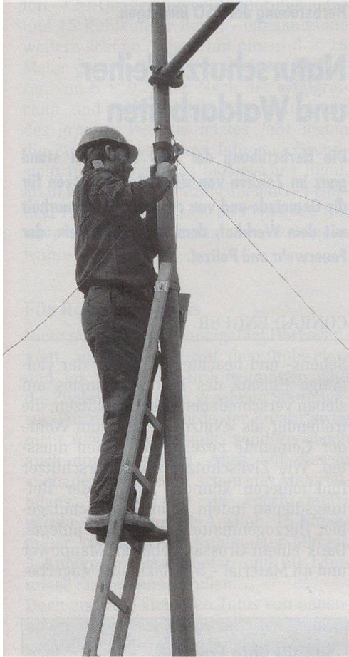
Leitungsbau in luftiger Höhe.
