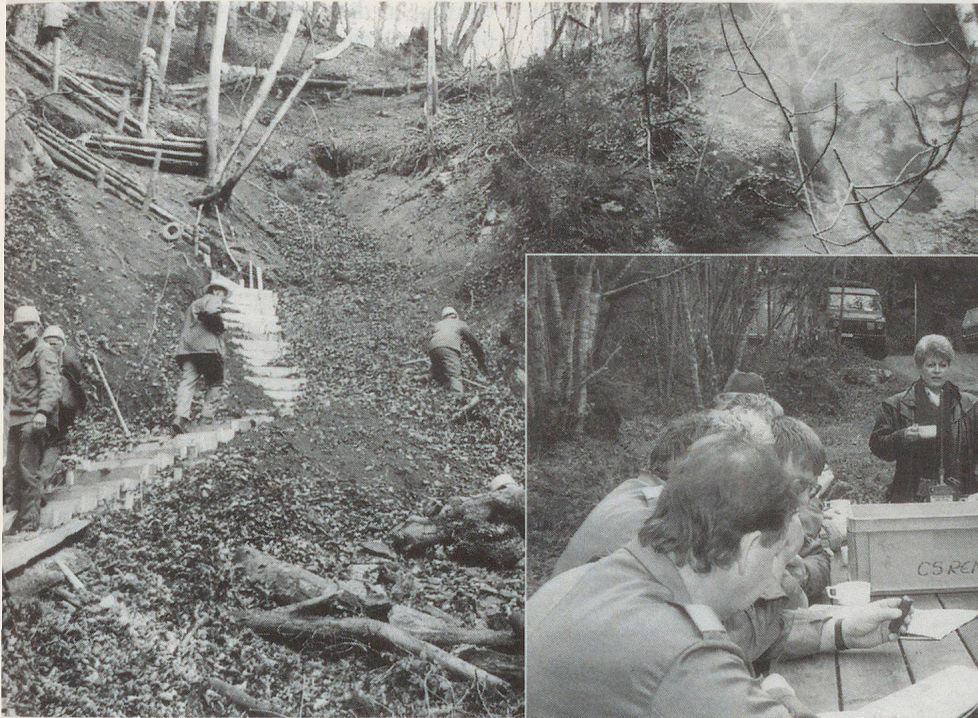
Un chantier difficile...
