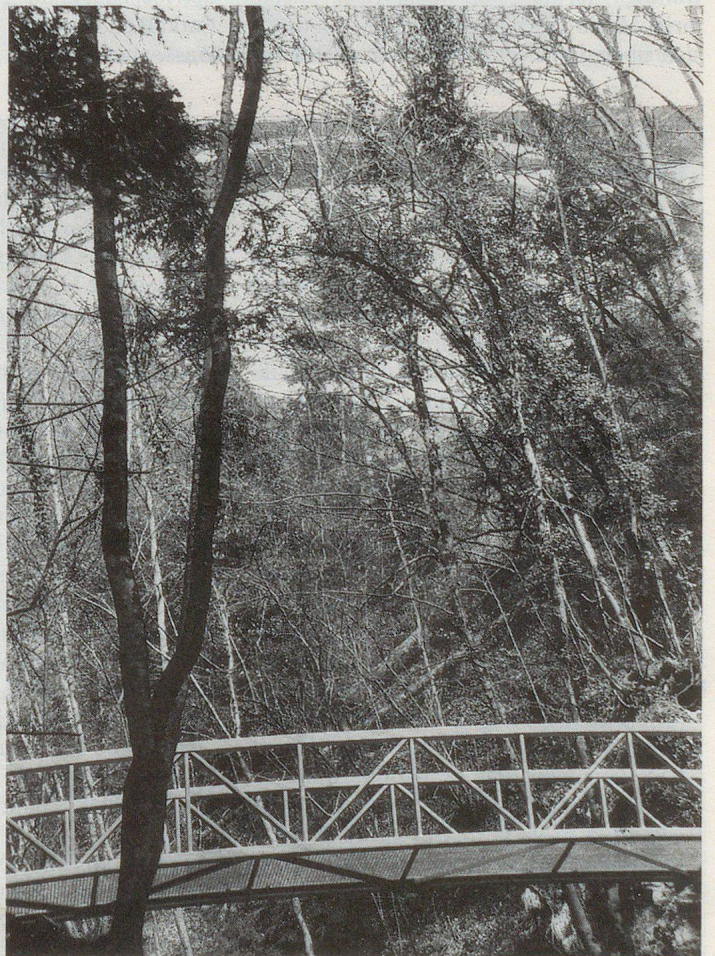
La passerelle métallique, plus haut le pont de la route des Mosses.
