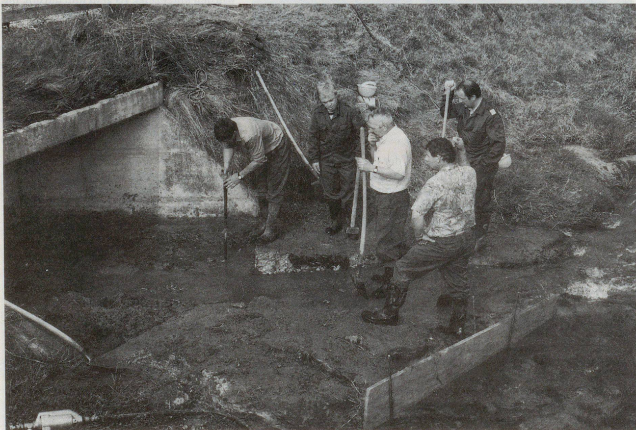
Ein Wasserlauf wird von Schwemm- material und Geschiebe befreit.
