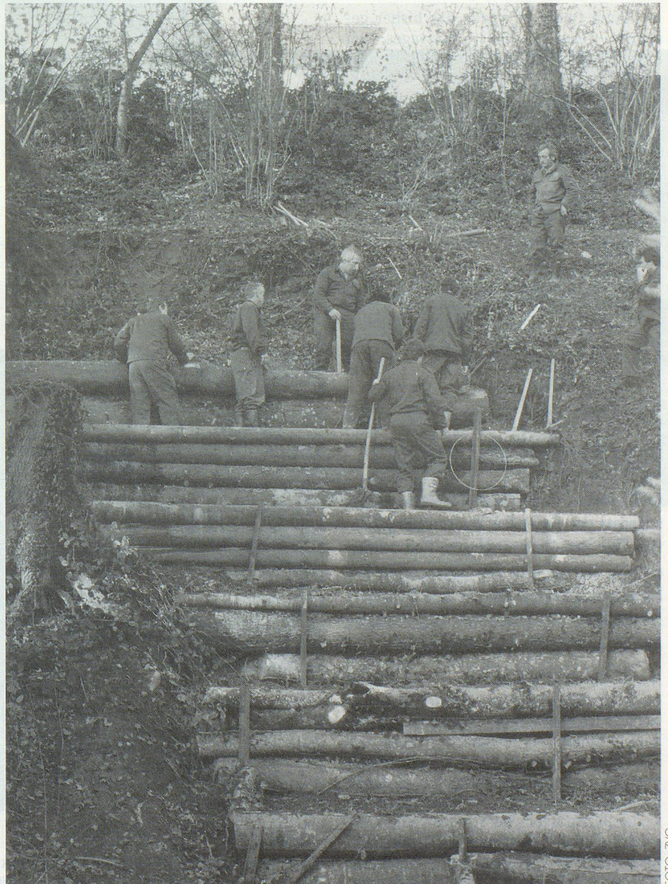
Massive Verbauung eines abgerutschten Hanges in Häggenchwil.
