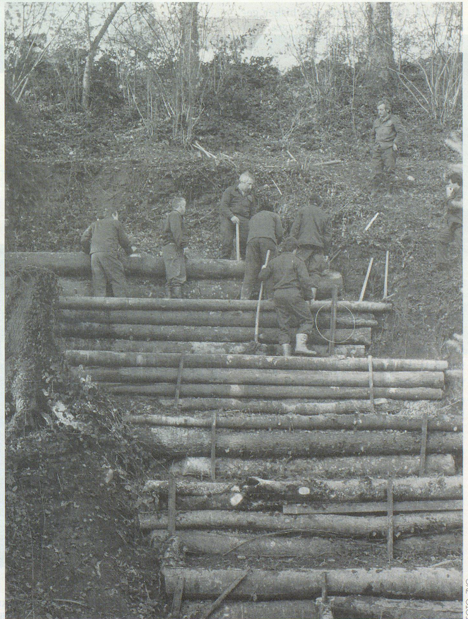
Massive Verbauung eines abgerutschten Hanges in Häggenchwil.
