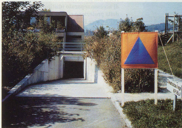
Abbildung 6 Aussenkennzeichnung (mögliche Beispiele) von Einzelanlagen (KP, BSA) der Zivil- schutzorganisation und von öffentlichen Schutzräumen sowie von Kombinations- anlagen der genannten Schutzbauten ohne sanitätsdienstliche Anlagen (Schutz- zeichen aus Textilmaterial [80×80 cm]). (Ziffer 51).
