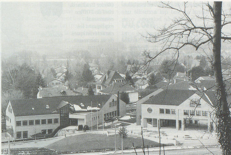
Le poste de commandement de l'OPC est situé sous le bâtiment de l'administration communale.
