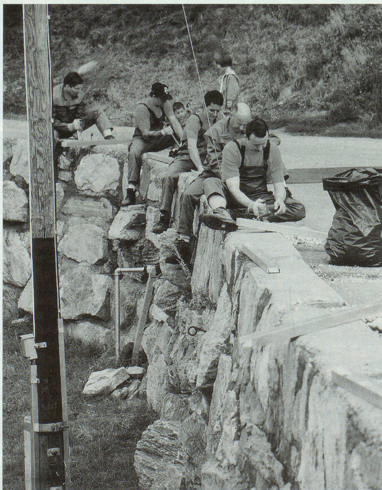
Die Reinacher Zivilschützer beim Bau des Sicherheitsgeländers entlang der Gemeindestrasse von Eggerberg.
