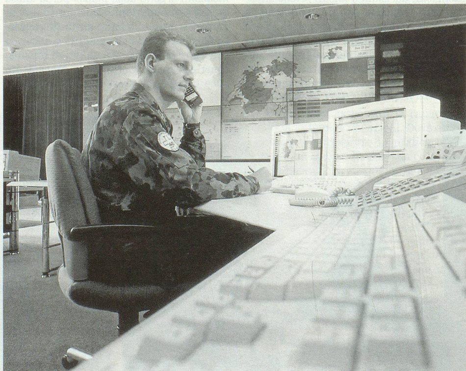
Das gesamte Netz der Swisscom wird durch Netzmanagementzentren überwacht.
