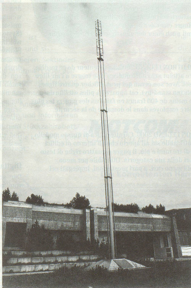
Antenne estraibili assicurano l'approvvigionamento radio con OUC in situazioni straordinarie.
