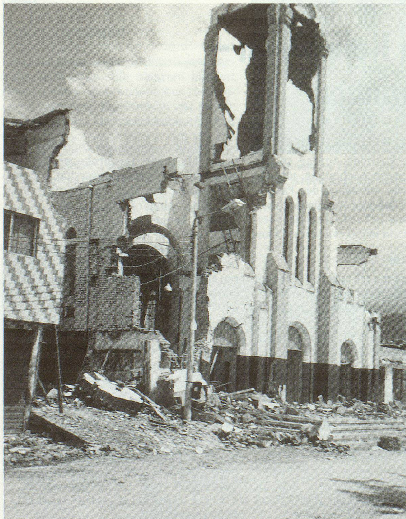
Stark beschädigte Kirche in Barcelona (Kolumbien).
