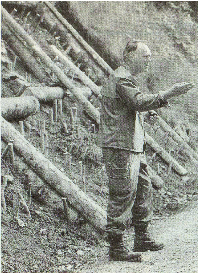
Diese soliden Hangsicherungen werden viele Jahre überdauern.
