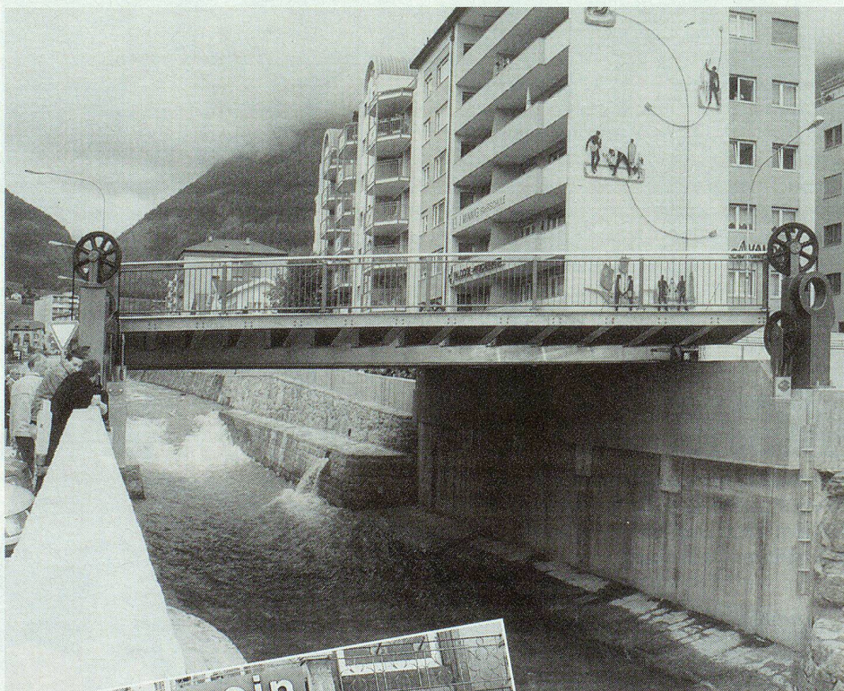
Auch baulich hatten die Walliser einiges zu bieten. Sie erstellten nebst anderen baulichen Massnahmen eine Hubbrücke über die Saltina.
