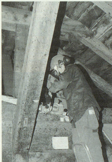
On s'occupe de la poutraison de l'étable.
