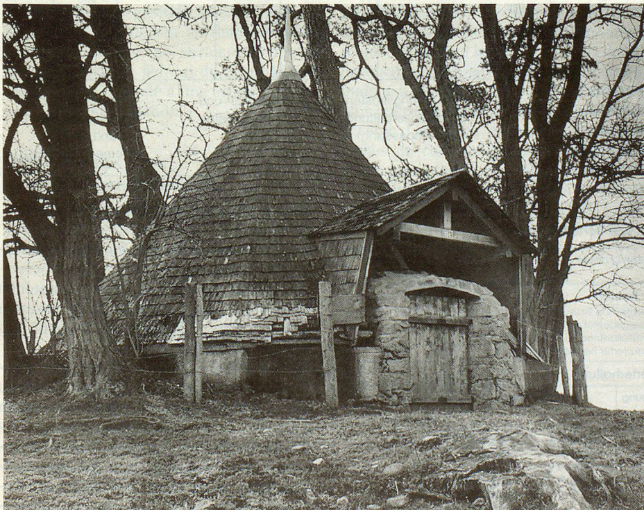
Der Eisspeicher in Greng – ein C-Objekt.
