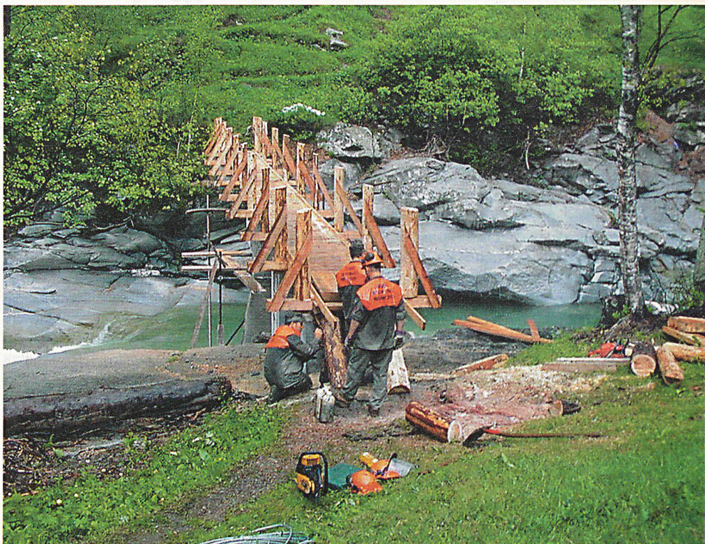
Appenzeller Zivilschützer leisten im Mai 2001 auf freiwilliger Basis Aufbauhilfe in der vom Unwetter schwer geschädigten Region Gondo.
