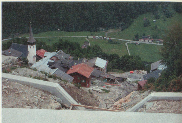
Schlans: neue massive Stützmauern.
