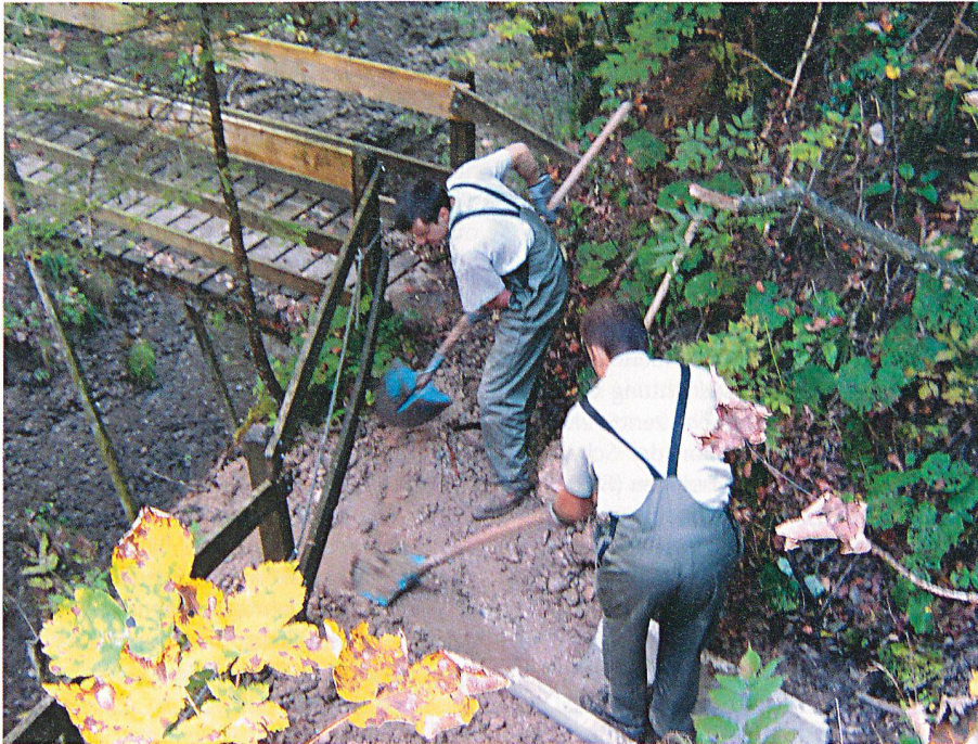
Beim Verlegen einer Betonhalbschale zur Wasserführung im Chratztobel.
