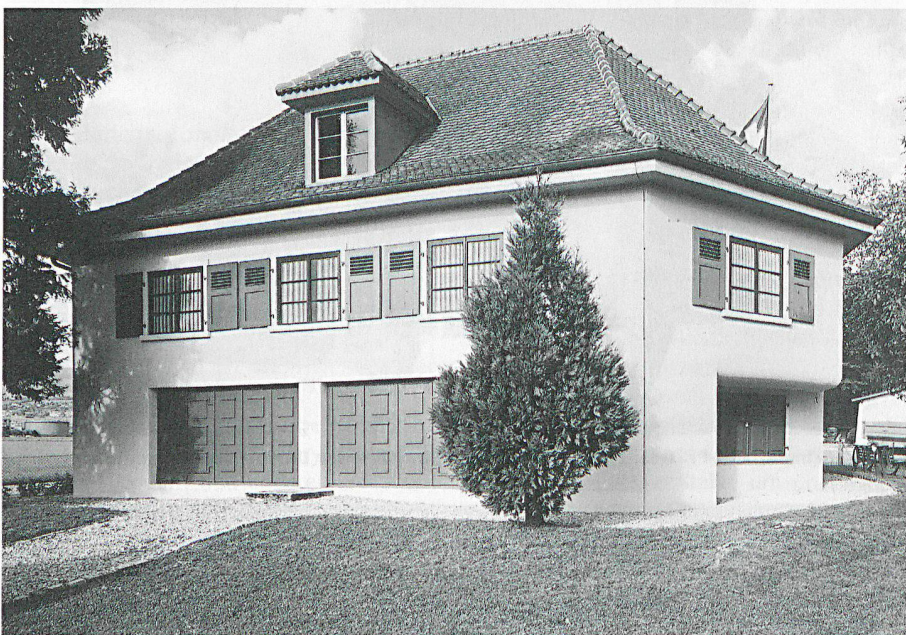
Infanteriebunker in Gland VD: Massivbau; hinter den aufgesetzten Fenstern sind, direkt auf den Beton, Vorhänge aufgemalt.
