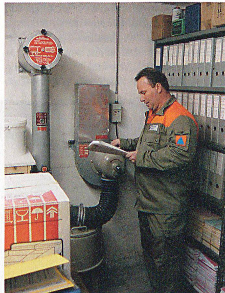
Stefan Salvatore überprüft ein Belüftungsaggregat.
