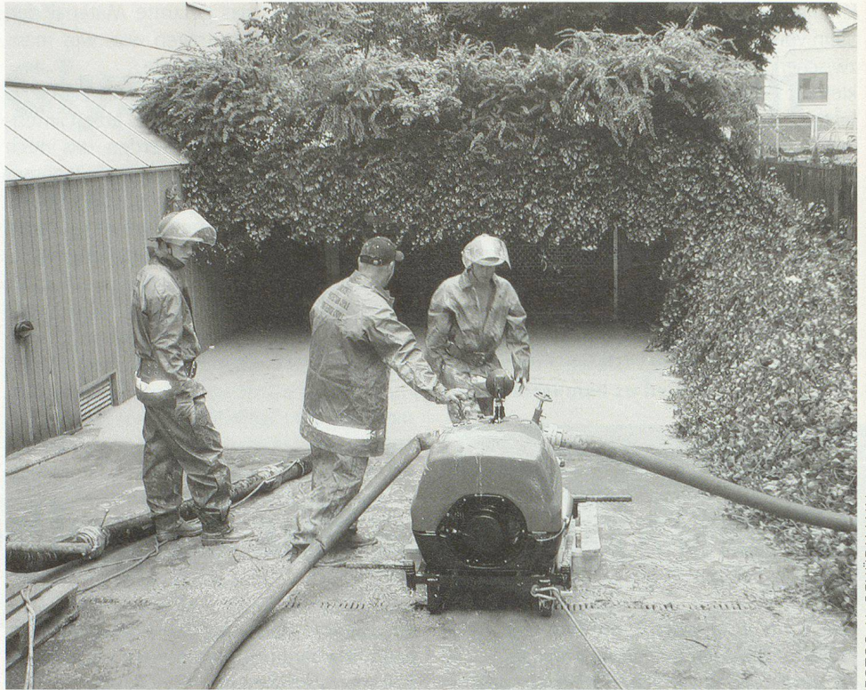
Zivilschützer beim Auspumpen einer Tiefgarage.
