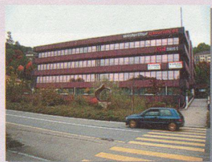
Bâtiment large (> 30 m) en métal et en verre
