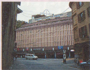
Parking couvert en béton armé (très petites ouvertures)
