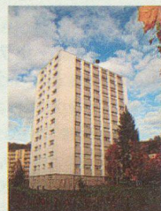
Immeuble locatif, béton armé
