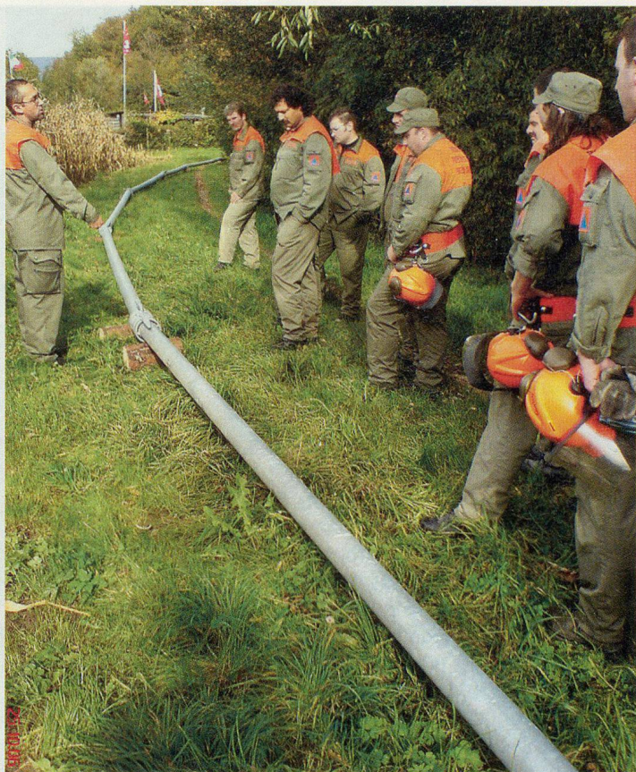
Die Notwasserleitung von Suhr nach Gränichen ist ausgetestet.
