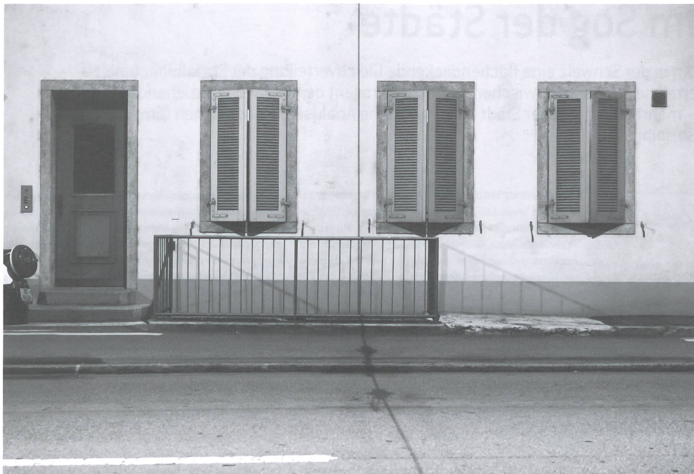
Es braucht Fördergelder des Staates, um Bauten zu sanieren und Genossenschaften zu unterstützen.
