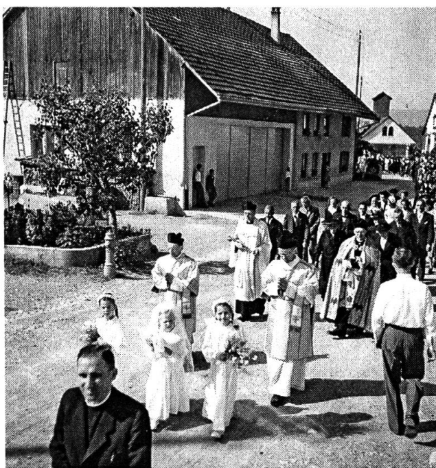
Abbildung 3: Die Primiz des späteren Missionsbischofs Josef Zimmermann brachte 1950 eine grosse Zahl auswärtiger Würdenträger nach Birmenstorf. Der Festzug nähert sich unter den Augen weniger Zuschauer auf der zentralen Achse der Pfarrkirche St. Leodegar. Der Fotograf steht auf der Aussentreppe des Gasthofs Bären, aus dem der Mann am rechten Bildrand gerade tritt. (Foto Missionsprokura der Heiligen Familie, Werthenstein).
