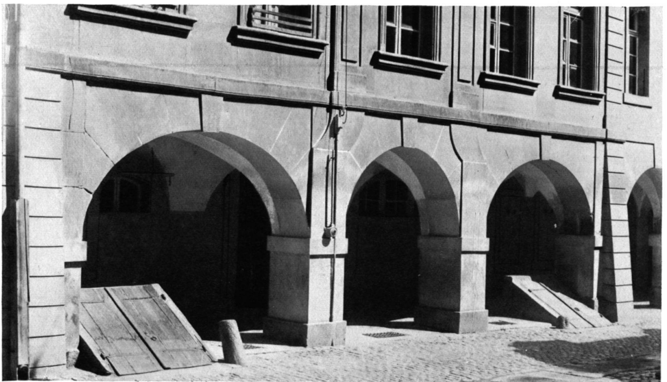
Lauben an der Postgasse mit den typischen „Kellerkästen“ oder Kellereingängen (Alte Post).
