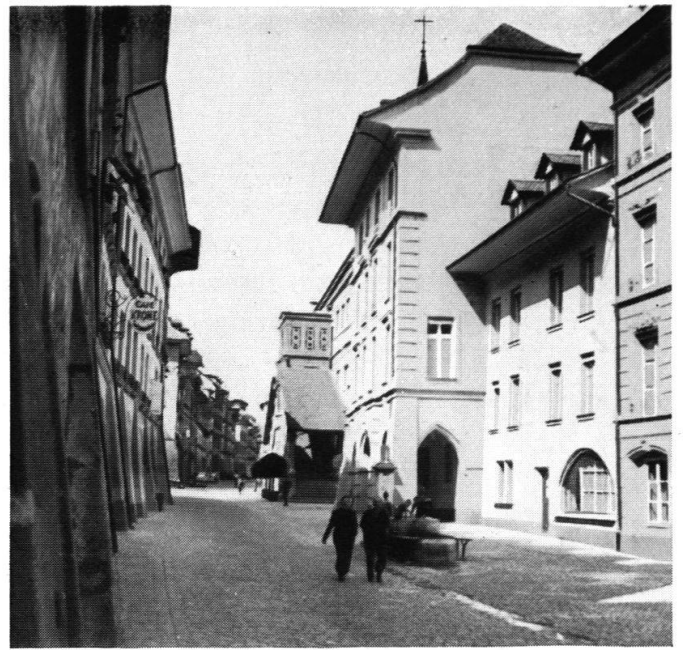
Das alte Staatsarchiv: Ansicht von Osten.
