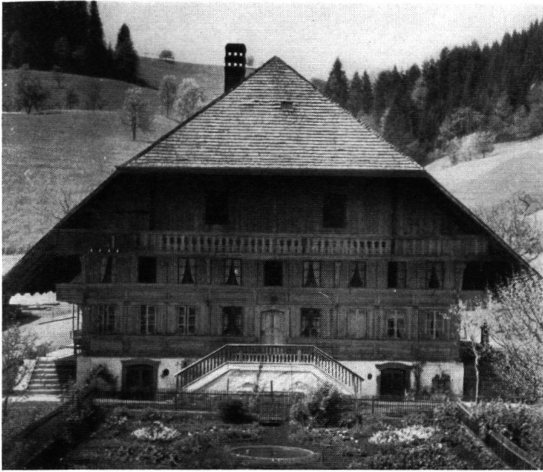
Das Haus vor der Erneuerung des Dachstuhls. Dieser datierte noch aus dem Jahre 1685. Keller, Stuben und Gaden sind in den Jahren 1827—29 neu errichtet worden. Ohne Zweifel ist die Zentrallage der Küche ursprünglich.
