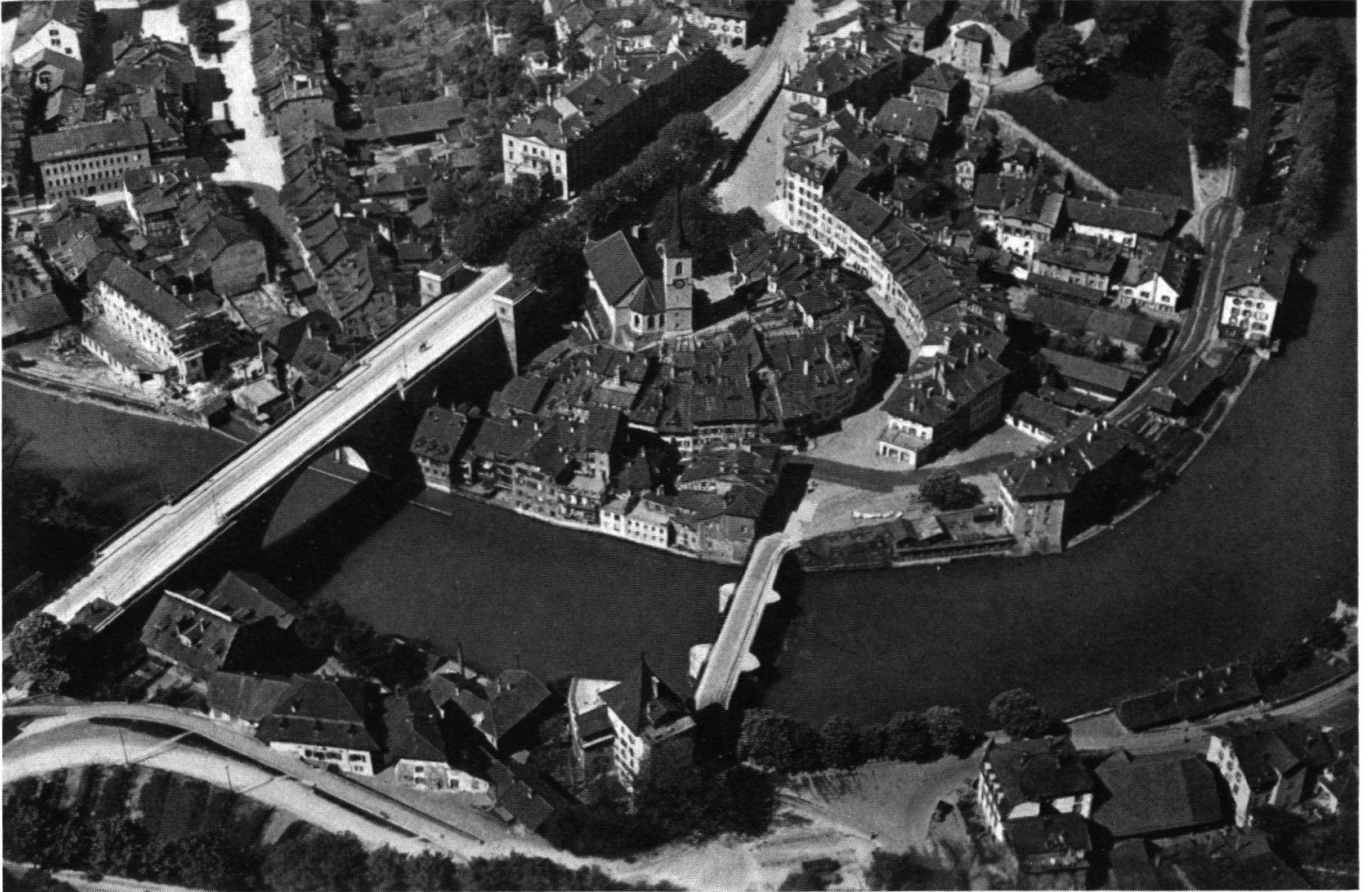
Untere Stadt mit Nydeggbücke. Die Brücke setzt sich gewaltsam über die topographisch bedingte Bebauung und Straßenführung hinweg.
