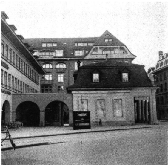
Die Verbindungsbögen zwischen Hauptwache und dem Neubau der «Winterthur».
