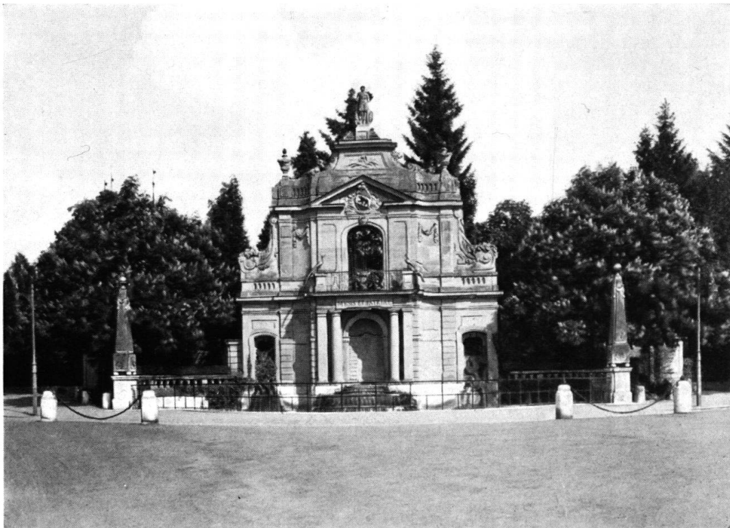
Die gleiche Fassade als Wasserschloß am Thunplatz (seit 1912). Photo Neeser.
