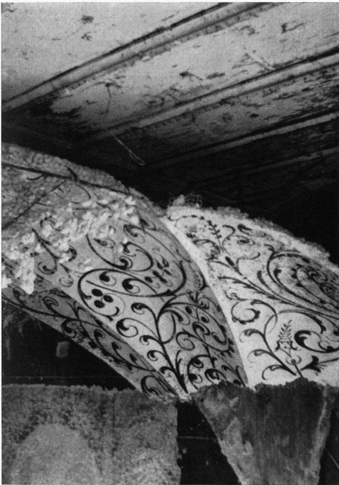
Kirche Kerzers: Unter dem «gotischen» Rabitz-Gewölbe von 1920 ist die hölzerne Flachdecke aus dem 17. Jh. noch erhalten. Sie konnte im Herbst 1959 freigelegt werden. (Photo H. v. Fischer)
