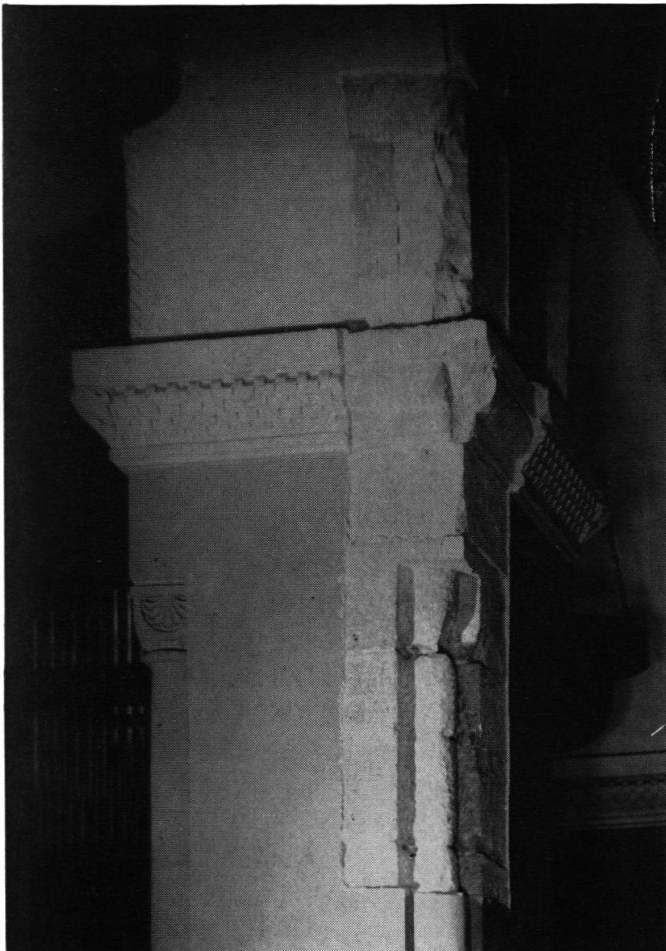
Eglise St-Germain in Moutier: Unter einer dicken Gipsschicht steckt die romanische Abbatiale von Moutier-Grandval (Photos A. Eichenberger, Moutier)
